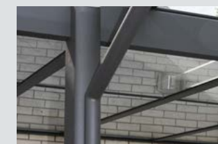
Tebau Flex in Dachfarbe beschichtetes Aluminiumfallrohr
