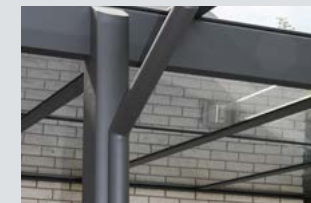
Tebau MaxPlus in Dachfarbe beschichtetes Aluminiumfallrohr
